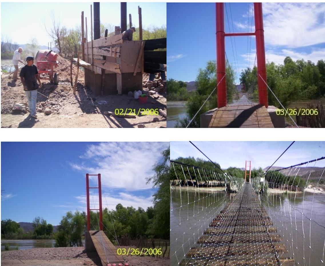
*(Fotografías que reflejan la construcción del puente colgante sobre el cauce del rio Nazas)*
