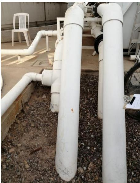
*Fig. 19 Tuberías entrantes al proceso (las tuberías de las norias están conectadas por debajo y se juntan en dos tuberías de 8").*
