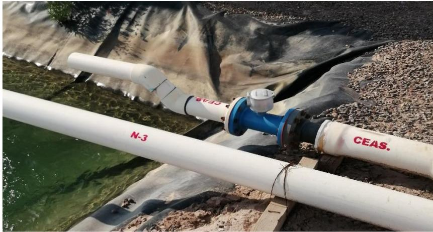
*Fig. 3 Medidor de tubería*
