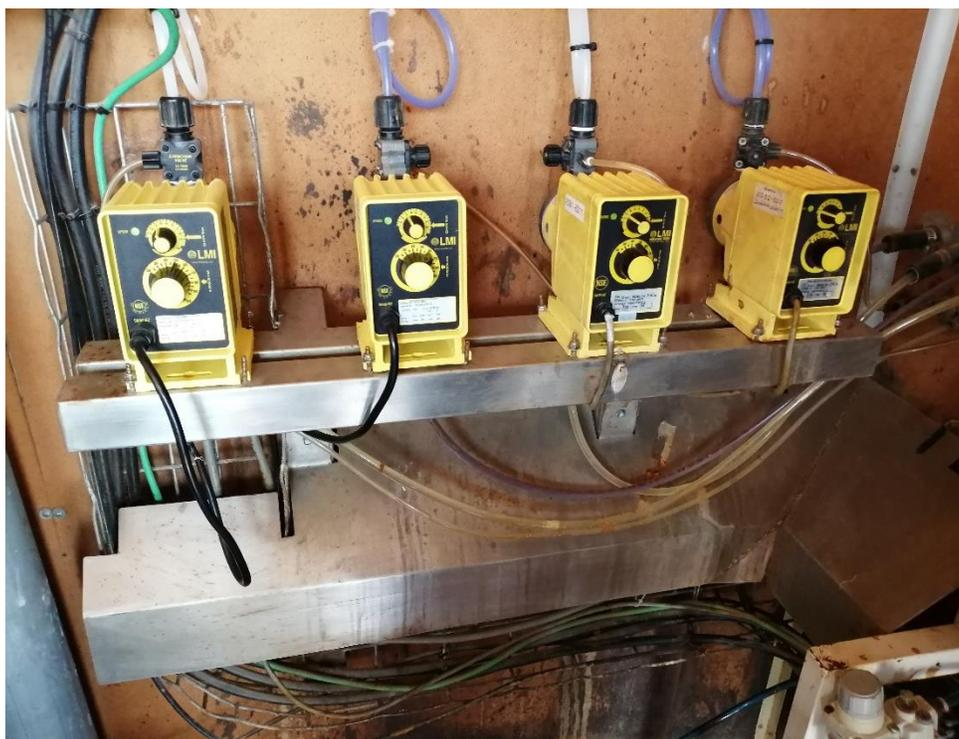
*Fig.9 Ubicación de líneas dosificadoras de coagulantes y floculantes*
