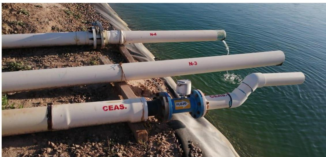
*Fig.13 Válvula noria N-3, tubería que desemboca al estanque*
