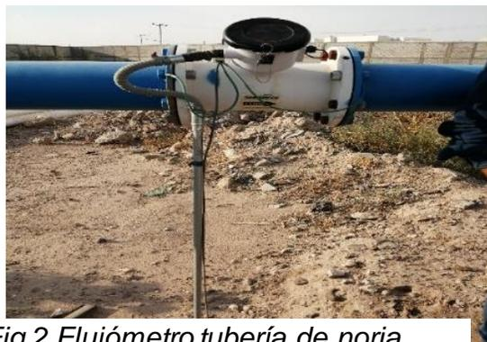
*Fig.2 Flujiómetro tubería de noria.*
