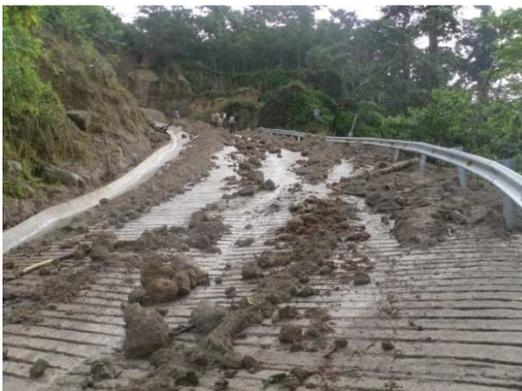
**Figura 13. Fotografía presencia de deslaves en la región del Soconusco del Estado de Chiapas.**
