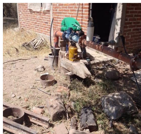
Figura 15.- Maniobra de recorte de ademe con gato hidráulico.
