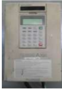
Figura 3.3.- Variador de frecuencia.
